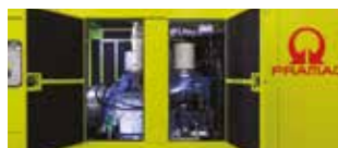
Большие двери для удобства осмотра и обслуживания
